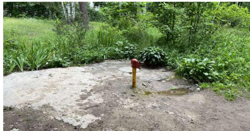
Функционирует питьевая колонка, оборудование устарело, требуется замена и обустройство площадки
